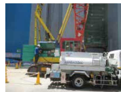
バイオディーゼル燃料の使用推進（建設機械に給油中）
